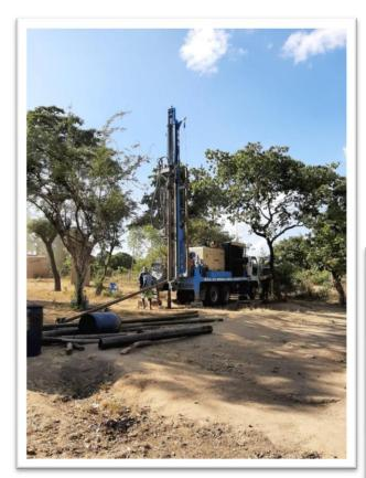
Die Probebohrungen verliefen erfolgreich. Der Bau des Brunnens dauerte einige Tage und war für alle Beteiligten vor Ort ein Ereignis. Es wurde zu einem Zeitpunkt gebaut, als die Schule ohnehin geschlossen war. Insgesamt wurde 160 Meter tief gebohrt, gegraben und anschließend die Pumpe installiert. Die Freude war groß, als das "erste" Wasser an die Oberfläche kam.
